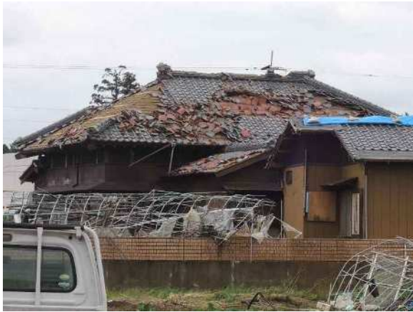
写真 3.1.50 住宅 K の屋根の状況（北西側）
