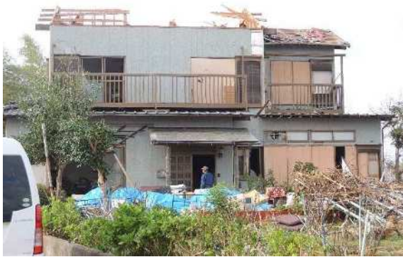
写真 3. 1. 33 住宅 H の外観
