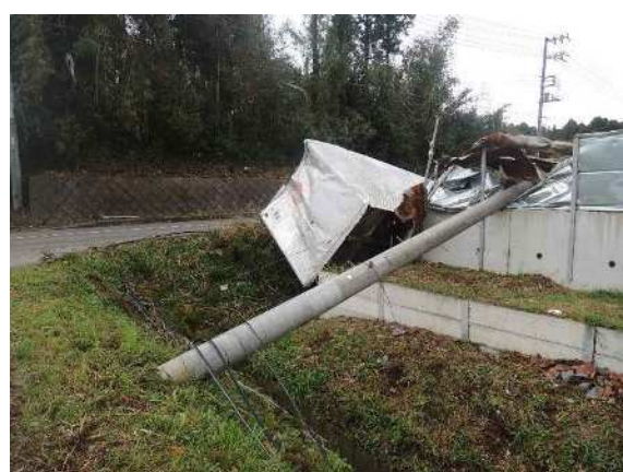
写真 3.3.23 電柱の折損
