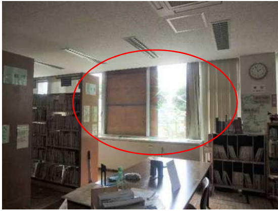
写真 3.2.3 写真 3.2.2 に示すガラスの養生状況
