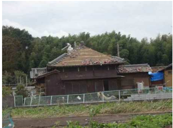
写真 3. 1. 49 住宅 K の屋根の状況 (北東側)
