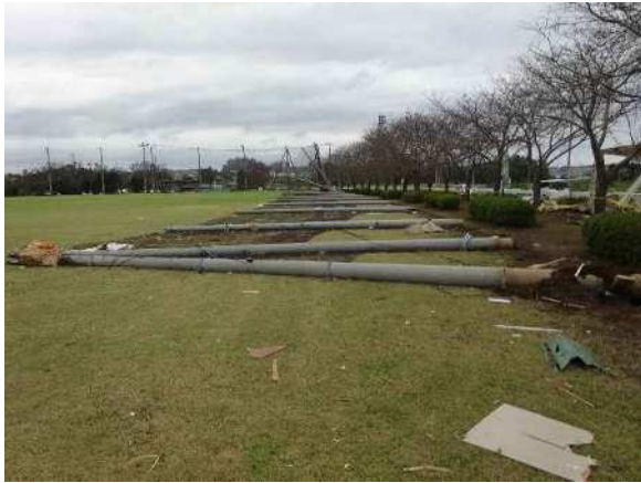
写真 3.3.18 コンクリート柱の倒壊状況
