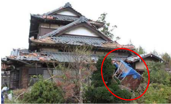
写真 3. 1. 13 住宅 C の外観 (東面)
