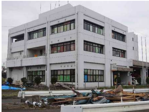
写真 3. 2. 13 消防署の外観
