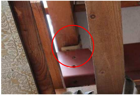
写真 3.1.7 小屋組のL型金物
