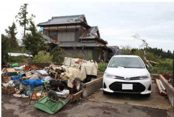
写真 3.3.5 倒壊した車庫 B
