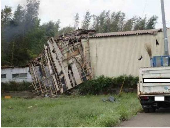
写真 3.3.11 倉庫 B の外観
