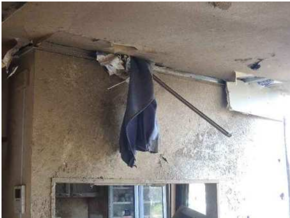
写真 3.1.43 写真 3.1.42 の室内側の状況
