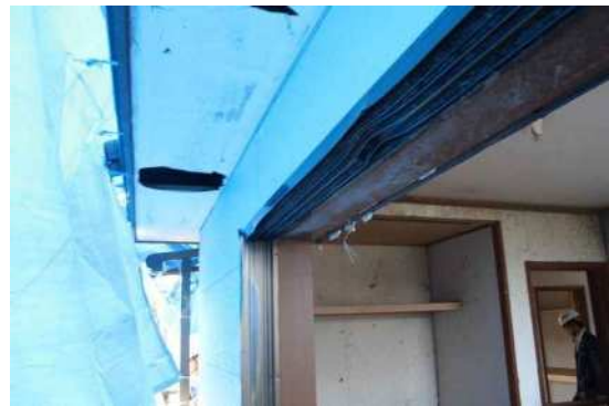
写真 3.1.26 2 階南側の窓と軒天井
