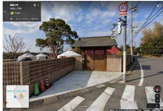
写真 3. 3. 16 倒壊した門の被災前の状況 (Google ストリートビュー(2019年3月撮影)より)
