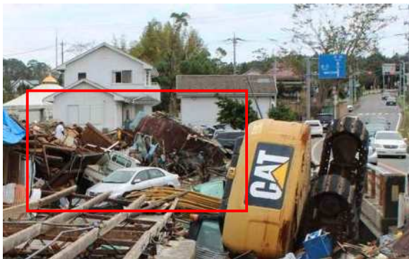
写真 3.1.21 倒壊した住宅 (赤四角部)
