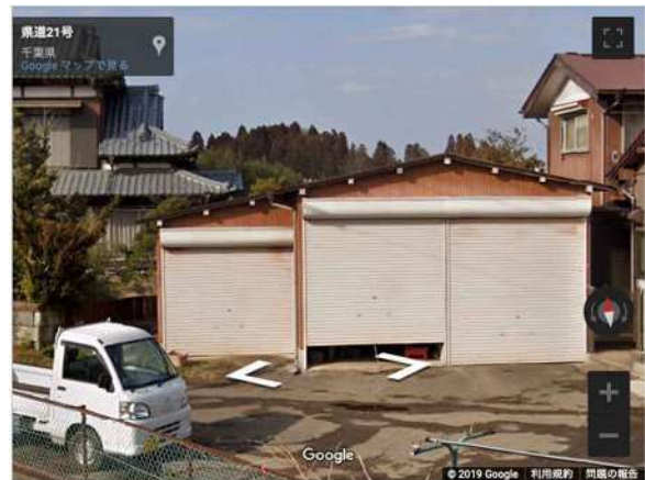
写真 3.3.6 倒壊した車庫 B Google ストリートビューより (2019 年 3 月撮影)
