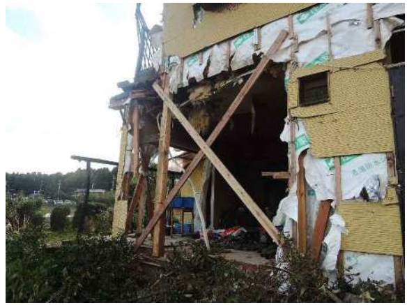
写真 3.1.42 損壊した壁面の応急措置の状況
