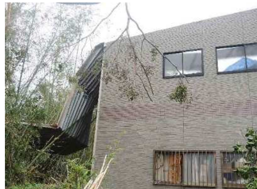
写真 3.3.10 折板屋根材の状況
