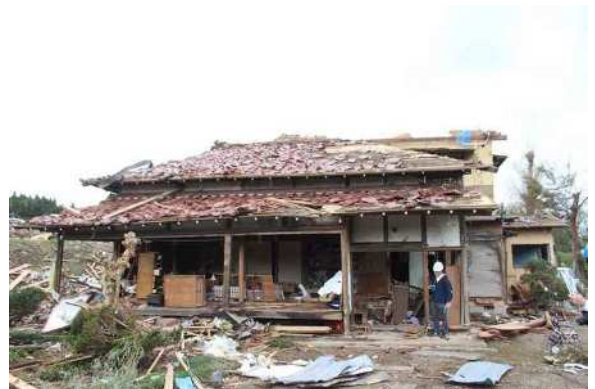
写真 3.1.10 住宅Bの外観 (南面)
