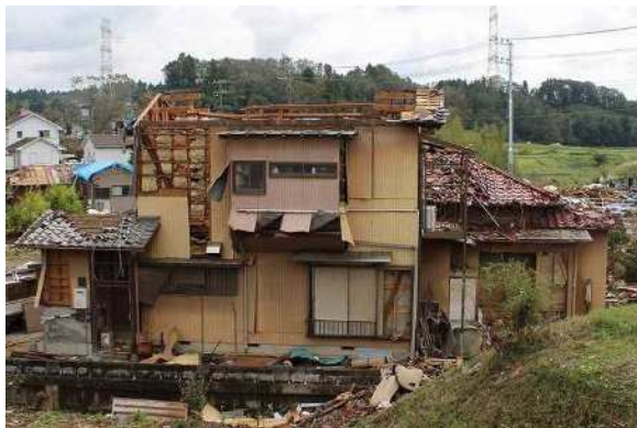
写真 3.1.9 住宅Bの外観 (北面)
