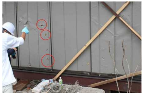
写真 3. 1. 16 瓦が突き刺さった雨戸
