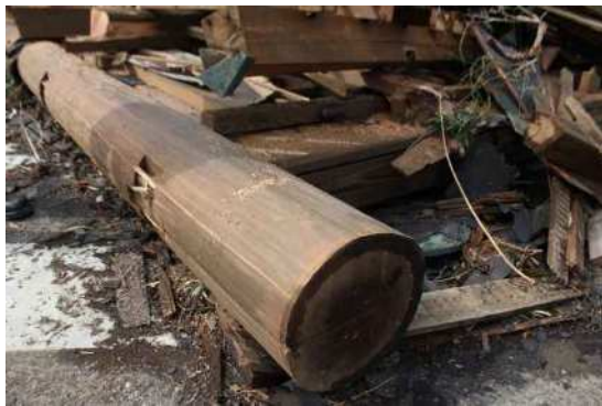
写真 3. 3. 17 倒壊した門の部材
