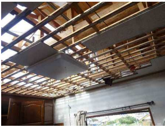
写真 3. 1. 35 小屋組が残っている 屋根の範囲の状況
