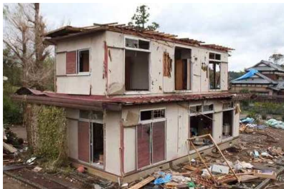
写真 3.1.1 住宅 A の外観 (南西面)
