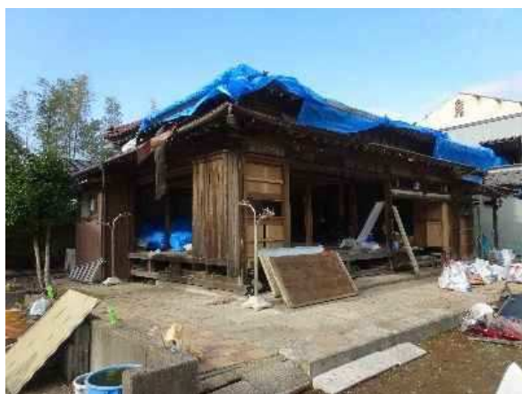
写真 3. 1. 38 住宅 I の外観
