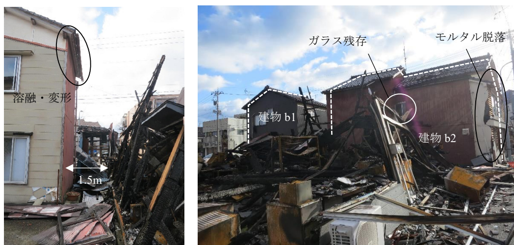
(ア) 北側から西面を見た様子
