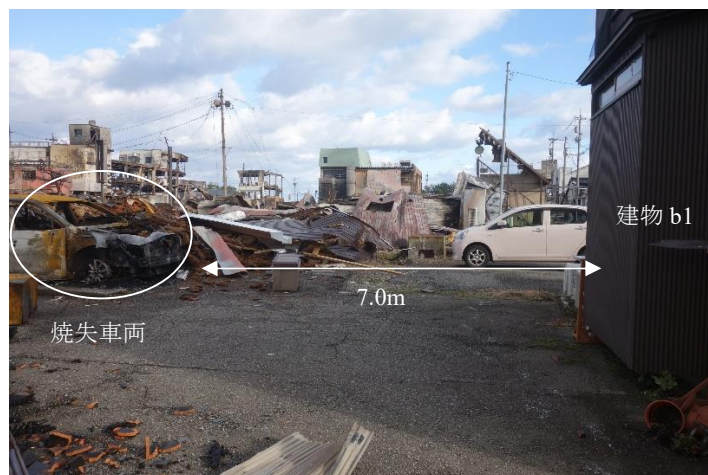
(ア) 西面（外壁面と焼けた車両）
