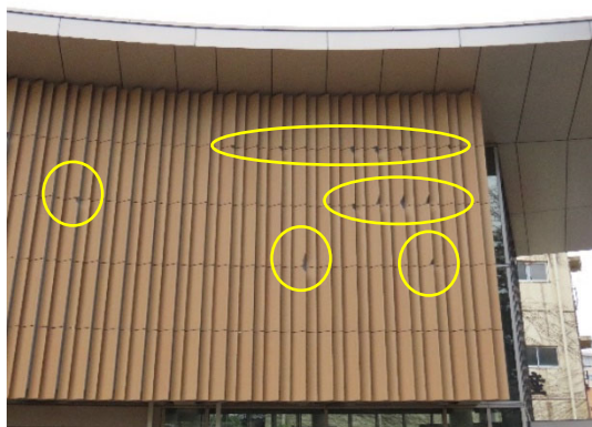
写真 B.3 外装の欠け
