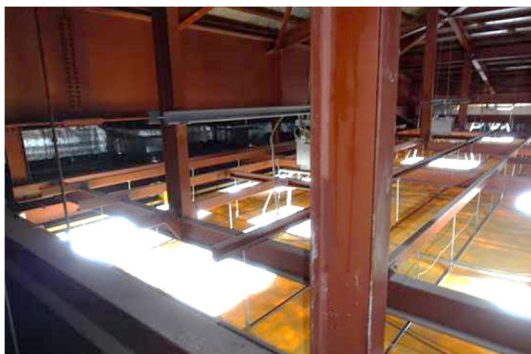
写真 C.4 垂れ下がり部分の支持状況
