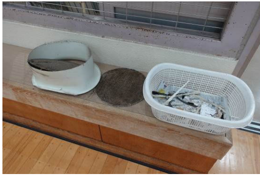
写真 G.6 脱落した部材
