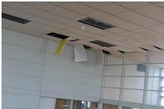
写真 C.2 グラスウール板の垂れ下がり
