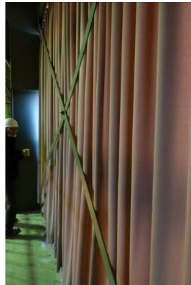
写真 K.3 ブレースの面外たわみ
