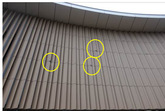
写真 B.2 外装の欠け
