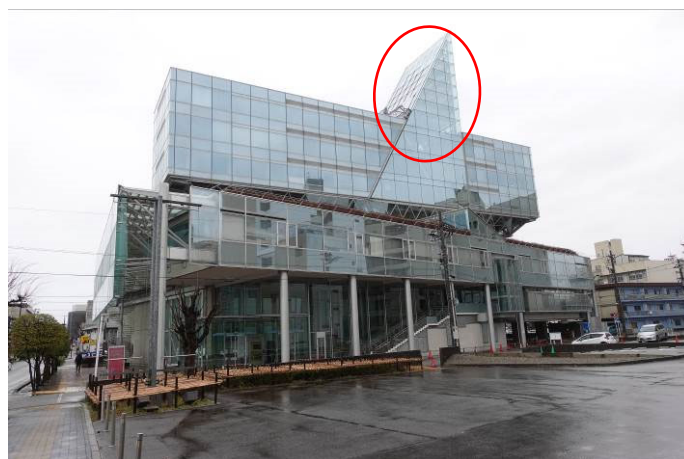
写真 N.1 外観（丸は外壁被害のあった三角形部分）
