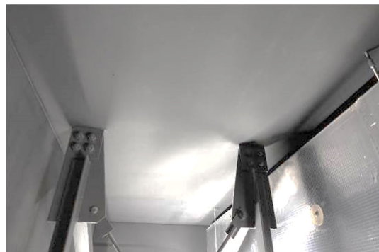
写真 F.9 支持部分の状況 (接合部はボードで覆われている)
