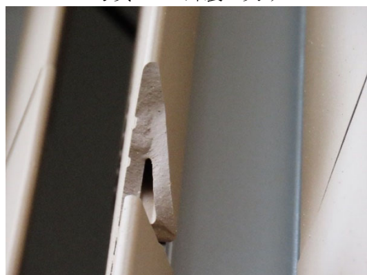
写真 B.4 外装の欠け
