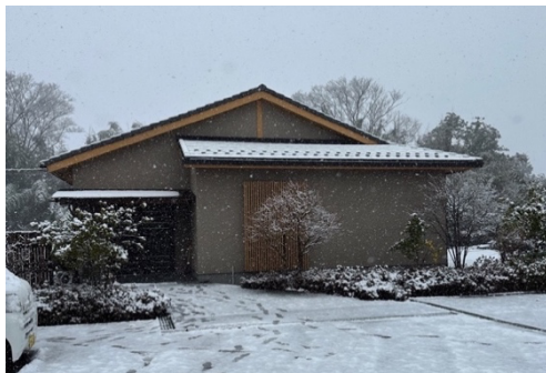
写真 2-1 ガイドライン工法による住宅 (珠洲市正院町川尻)
