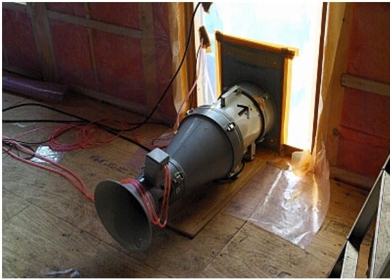
写真1 気密性能試験の様子
