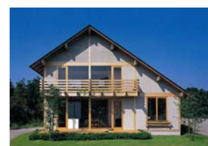
外壁真壁の外観
