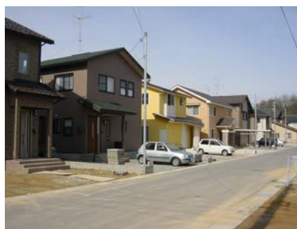
●外構整備が未完成のままの住宅
