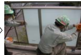
ハルユニット取付け
