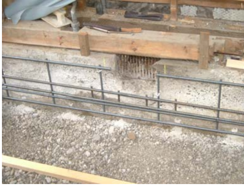
◆RUM-BR工法：配筋施工中
