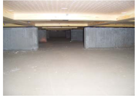
【束が無い1階床下空間】
