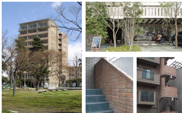
④長く保ち剥離しないレンガの腰壁
