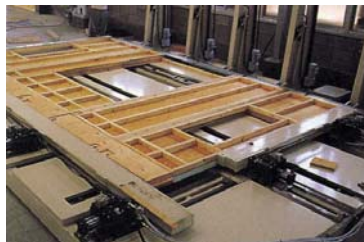
【軸組材とパネルの組付】 工場生産比率の高さから、高い品質安定性を有します。
