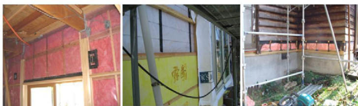
充填断熱気密工法
