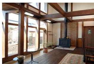
高窓からの採光と蓄熱土間
