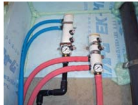
【②ヘッダー前圧力ゲージの設置】
