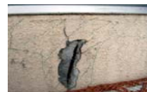
コンクリート爆裂部
