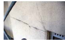
窓回りのひび割れ
