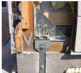
画像中央：オリジナル耐震金物「シェイクブロック」施工状況
