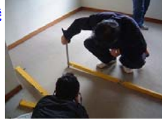
鉄筋探査機による検査
