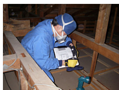
【小屋裏診断の様子】
