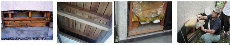
(写真下) 基礎鉄筋の有無を調査、無筋の場合は添基礎など補強を施す。右は基礎外周に断熱材施工
