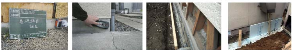
2. 床下の乾燥状況を調査、必要に応じて防湿工事を行う。天井壁屋根の防湿工事を行い、換気システムで室内の湿度を管理する。(写真は工事事例)
