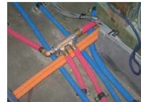
ヘッダー配管
