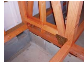
耐震補強、基礎補強
