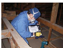
【小屋裏診断の様子】
