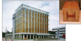
○木質ハイブリッド構造部材を使用した耐火建築物
