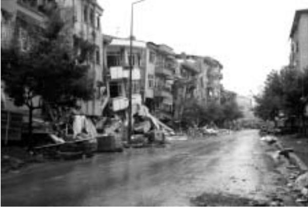
写真 コジャエリ地震でのアダバザリ市街の被害（通りの両側の5階建て建物：下層部が崩壊し上の3層分あるいは4層分のみ残存）
