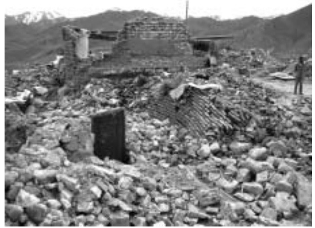
写真 35 Hotkan 村の被災状況
