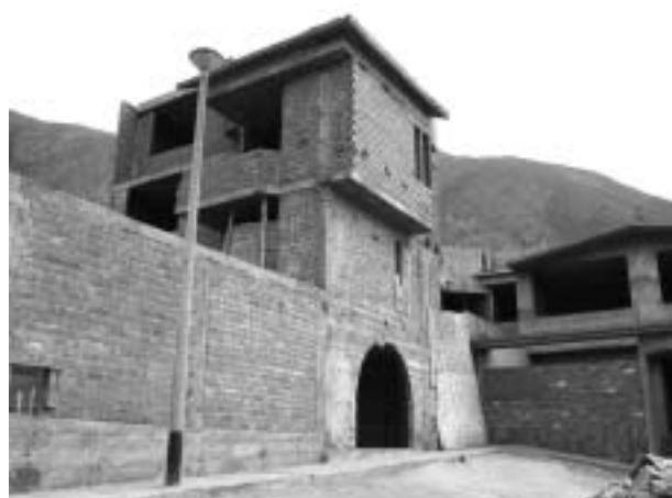
写真 30 れんがを用いた枠組み組積造
