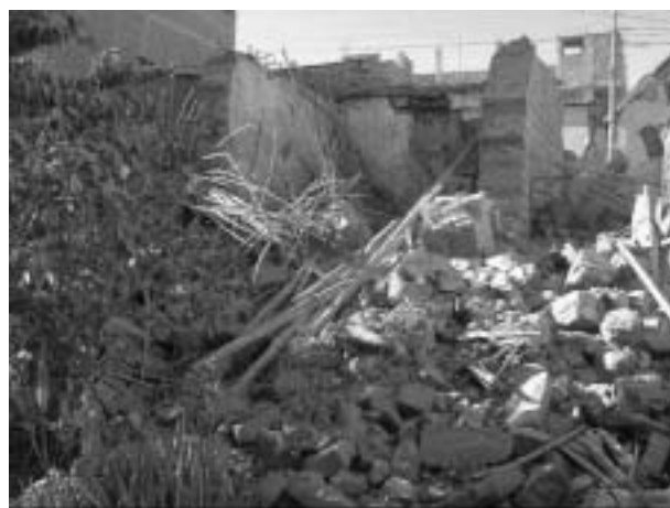
写真 31 倒壊したアドベ組積造
