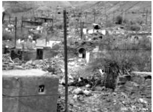
写真 36 Dahoueyeh 村の被災状況
