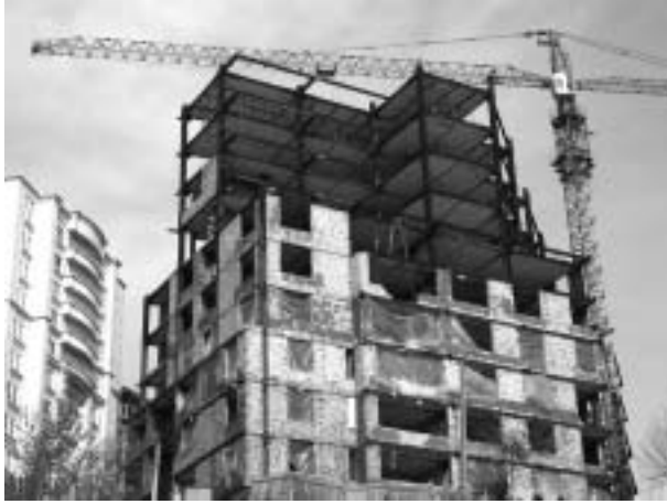
写真 33 テヘランの鉄骨造新築工事
