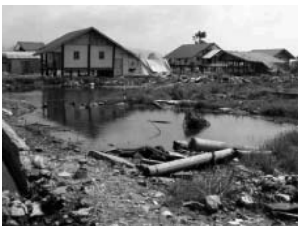
写真－4 復興住宅の建設が進んでいる様子。排水施設、上水等との不整合が指摘されている。
