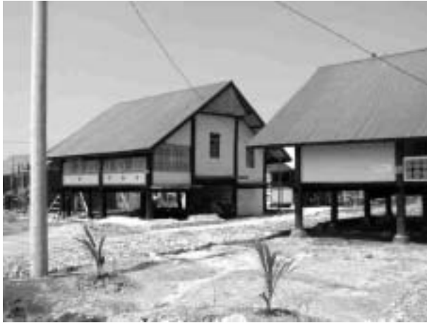
写真－9 ムスリム・エイドによる椰子の木を用いた住宅。伝統的住宅の特徴を生かした設計であり目立つ存在となっている。
