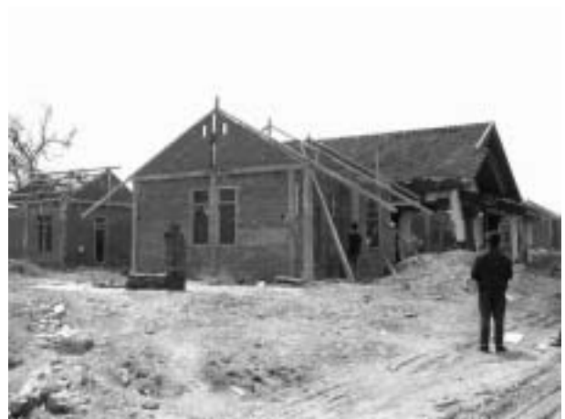
写真－12 同タイプの工事中の住宅
