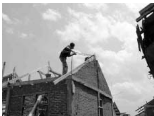
写真一23 工事中の状況 組み立てられた鉄筋を設置している
