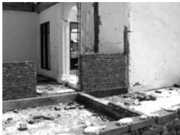
写真－14 同左の工事の状況 残存している部分に融通無碍に新たな部分が 増築されている
