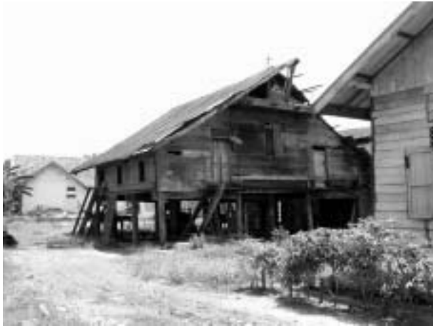
写真一五 バンダアチェ市内の伝統的な木造住宅。津波により建物全体が50cm程ずれているが原型をとどめている
