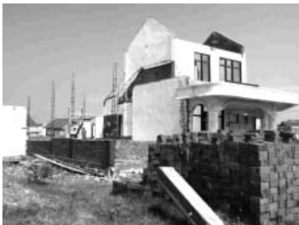
写真－13 修復プロジェクトによって工事が進んでいる住宅
