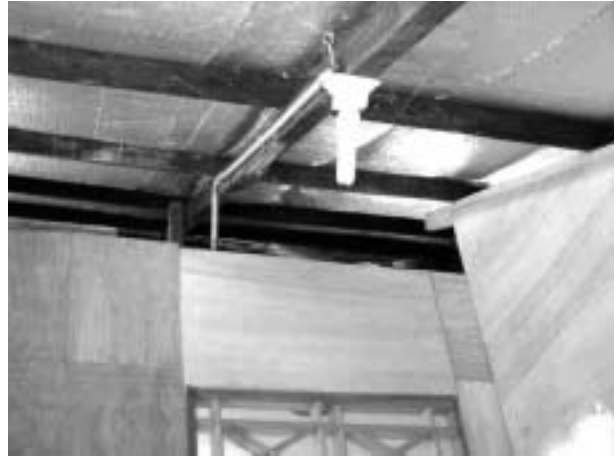
写真－10 天井の断熱シート
