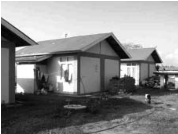
写真一七 工場で作成されたコンクリートパネルを組み立てる方式。
