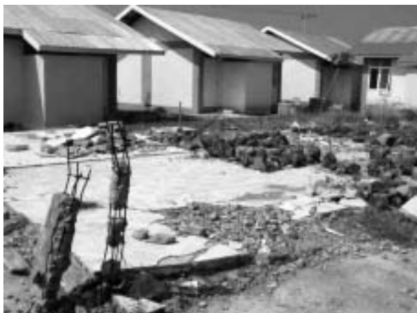
写真－3 災害の残骸が残る一方、復興住宅の建設は着実に進んでいる。
