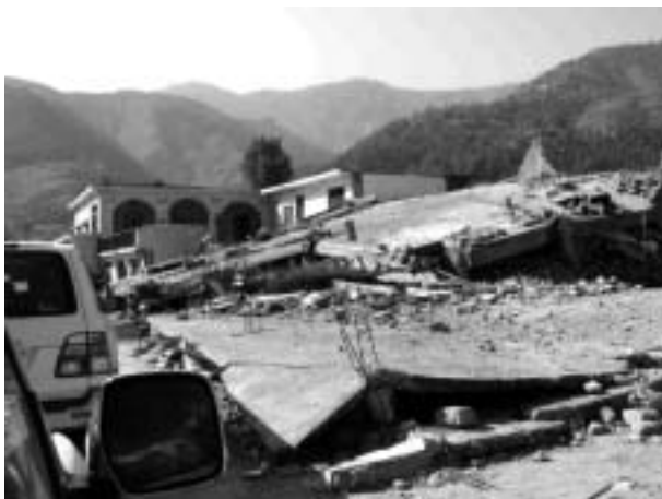
写真-26 町の中心部では RC フレーム建築物が一般的であるが、ほとんど倒壊している。
