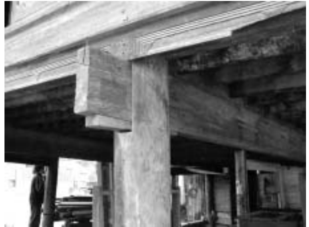
写真一六 同上詳細。床を支える根太。密実な木材で、断面も相当大きい（6.5cm×40cm）
