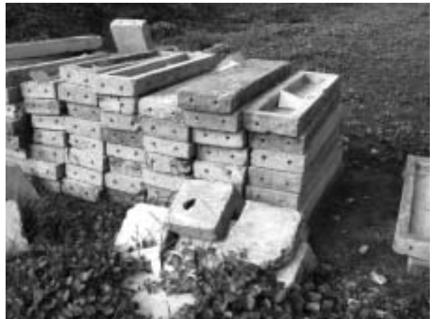
写真一八 使用されるコンクリートパネル（写真は不良のため除外され、野積になっているもの）
