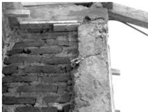
写真-18 コンクリートに入っているスリット。中央は型枠の隙間からコンクリートが流れ出ることを防ぐためと思われる紙。
