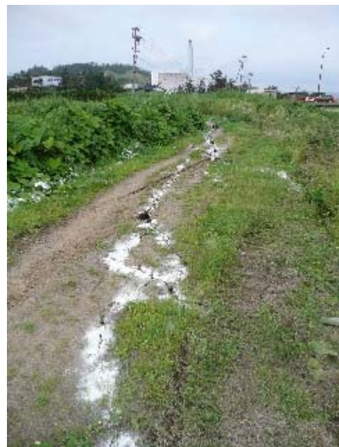
写真 5.52 ひび割れの進む方向にある 損傷したクリーンセンターの煙突
