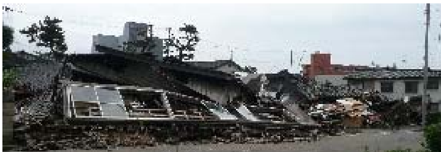
写真 5.28 倒壊家屋が連続する新花町
