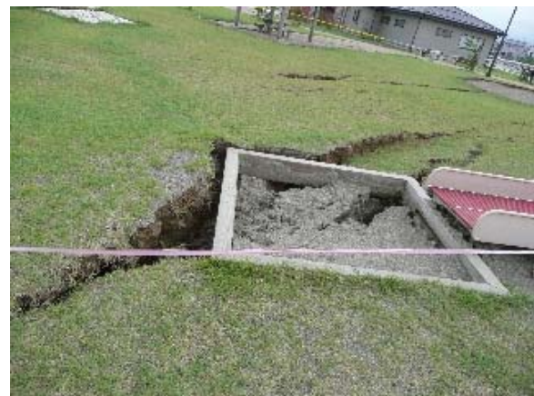
写真 5.48 鯖石川記念公園の遊具施設を貫く 地面のひび割れ
