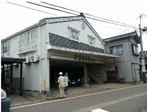
写真 5.38 1階に大きな車庫を取り、鉄骨と木造を併用した例
