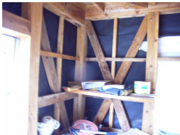
写真 5.8 写真 5.6 の筋かい
