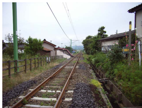
写真 5.10 線路に向かって倒壊した家屋
