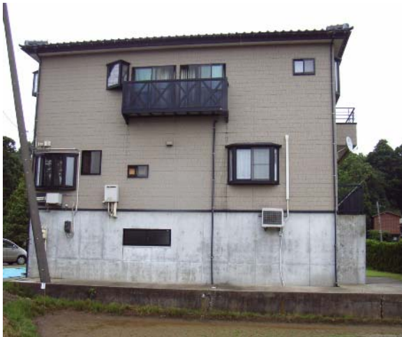
写真 5.5 ほぼ無被害の高床式住宅
