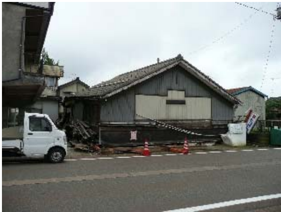
写真 5.36 倒壊した店舗併用住宅
