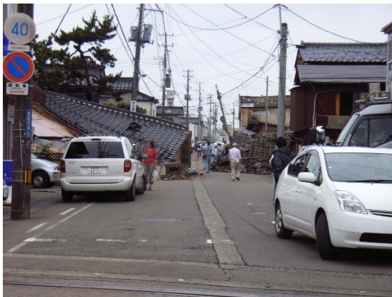
写真 5.9 東本町3丁目の倒壊家屋群
