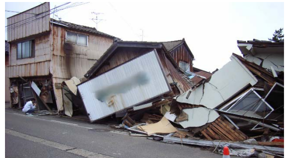
写真 5.12 倒壊した店舗併用住宅
