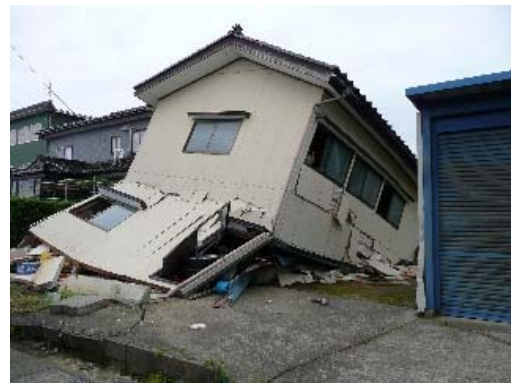
写真 5.18 倒壊した比較的新しい車庫兼作業所
