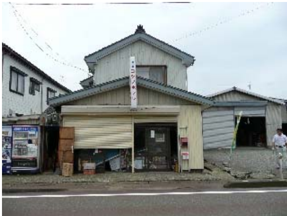
写真 5.23 地盤変状により被害を受けた店舗 併用住宅
