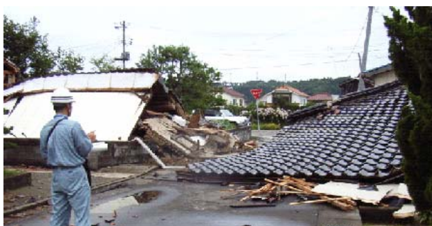
写真 5.1 倒壊して道路を塞いだ木造家屋
