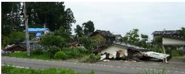
写真 5.17 多くの車庫、倉庫が倒壊
