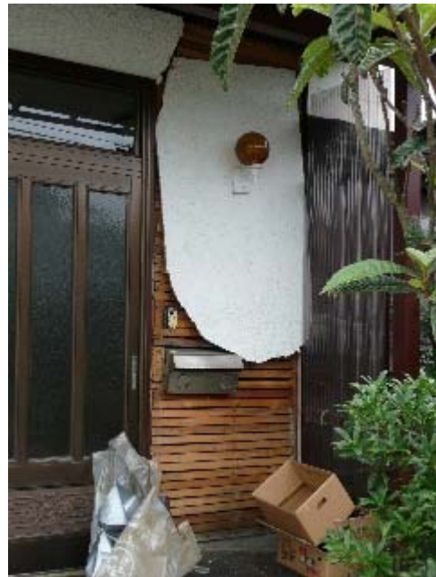
写真 5.22 写真 5.21 の住宅の現幹部分 (筋かいが入っていない)
