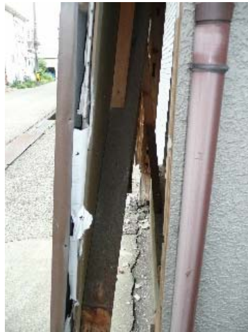
写真 5.42 開口脇の無開口壁に入る正角筋かい
