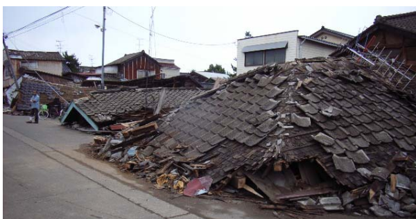
写真 5.11 軒並み倒壊した古い構法による家屋
