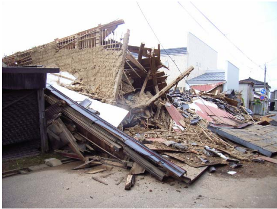
写真 5.15 土壁を有する古い構法の家屋
