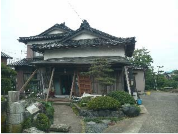
写真 5.19 大破した比較的古い構法による住宅
