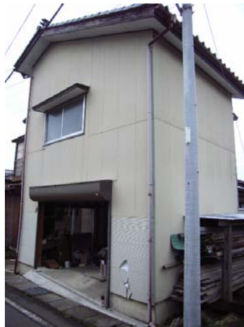
写真 5.6 外観上無被害の車庫
