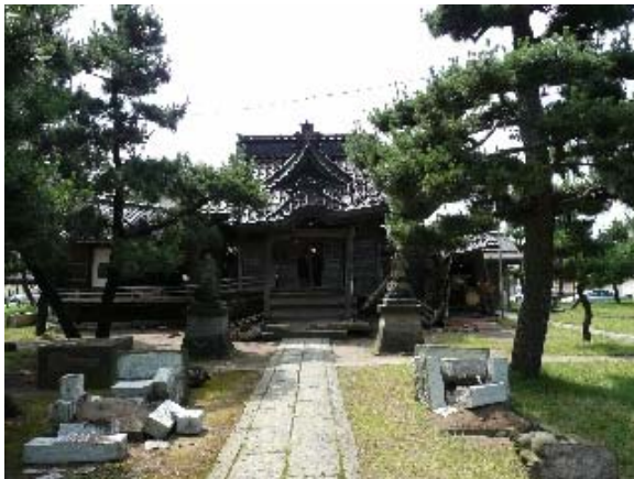
写真 5.33 壊滅的な被害を受けた新花町の金比羅宮
