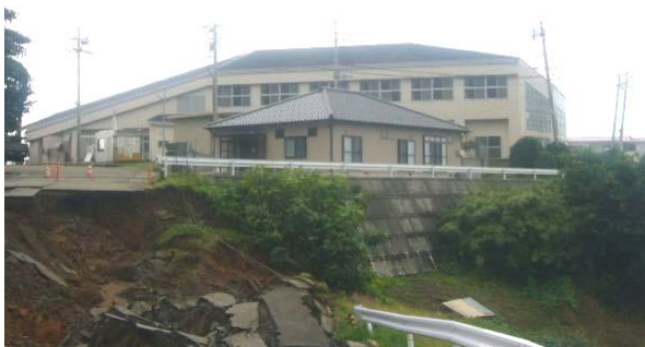
写真-43 建物M 外観
