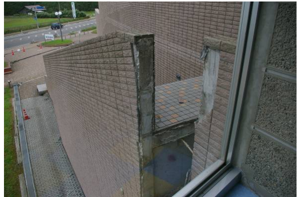
写真-21 大きく傾斜・移動した外部階段
