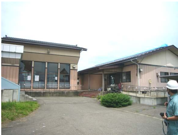
写真-16 建物Dに隣接して建つ建物
