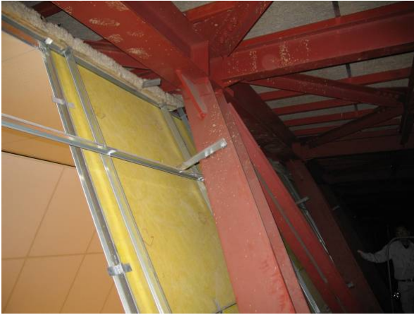
写真-32 プロセニウムアーチ上部の天井裏
