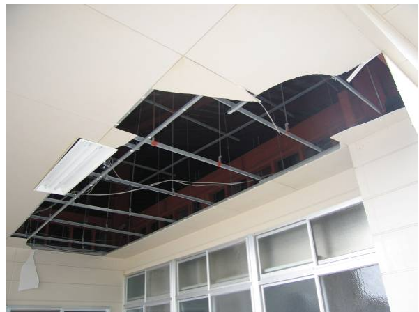
写真-44 脱落した軒天井
