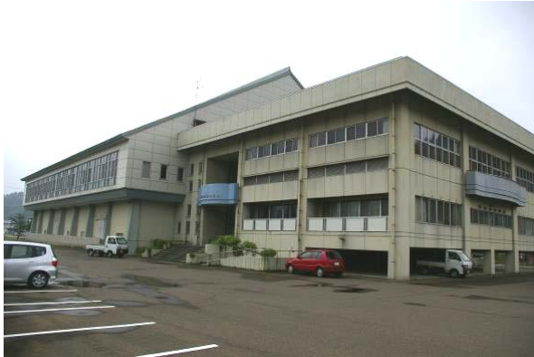
写真-28 建物G外観
