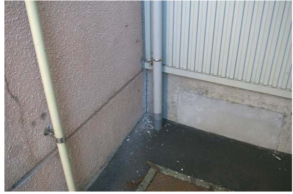
写真-40 増築部分の接続箇所
