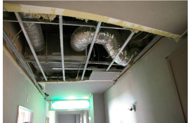
写真-46 廊下の天井の脱落
