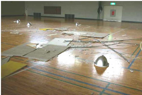
写真-26 脱落した様々な部材
