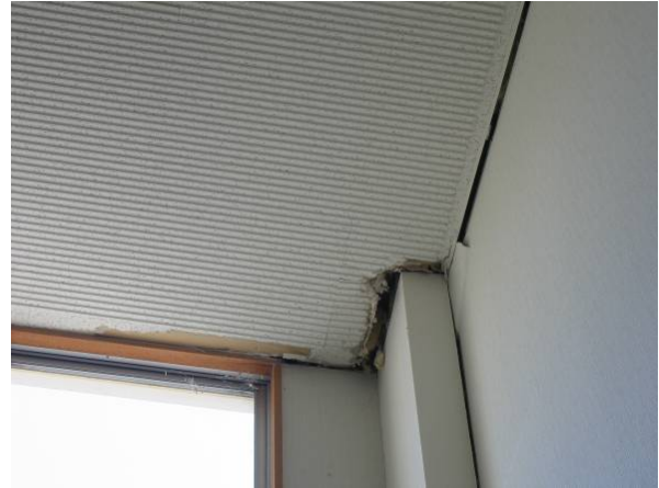
写真-37 吹き抜け上部の天井被害
