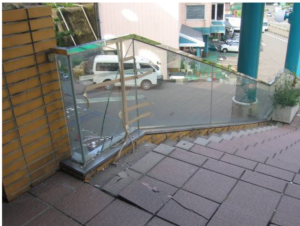
写真-47 手すり支持部のガラスの破損
