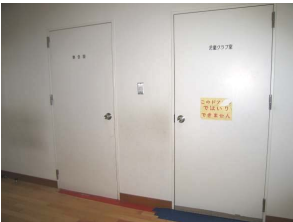
写真-34 開扉に支障を来した防火扉
