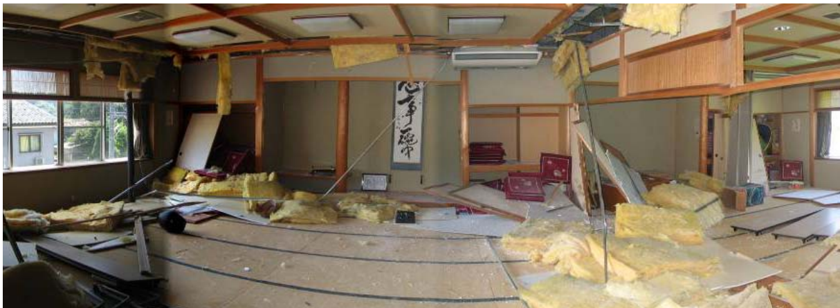
写真-38 2階和室内部被害状況（パノラマ合成）
