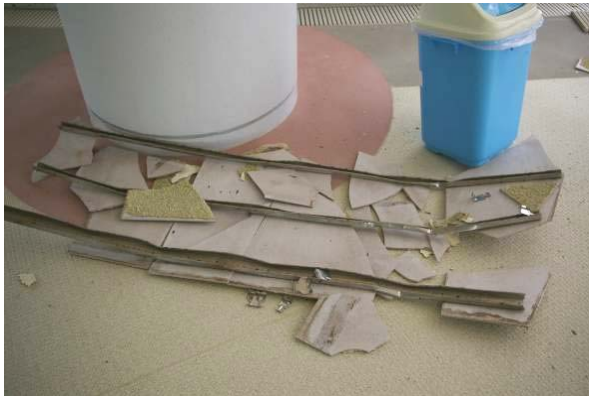
写真-20 脱落した天井下地と天井板
