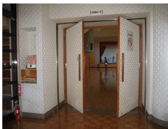
写真-2 不具合が生じた扉
