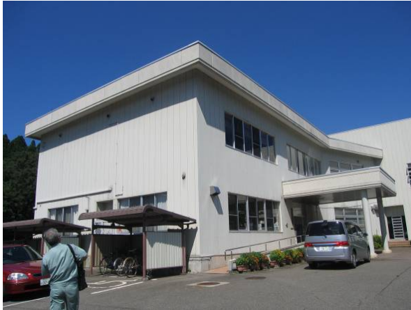
写真-36 建物J外観
