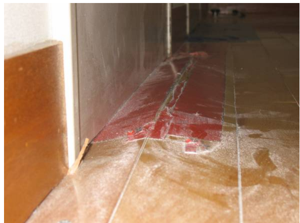
写真-35 床仕上材のせり上がり
