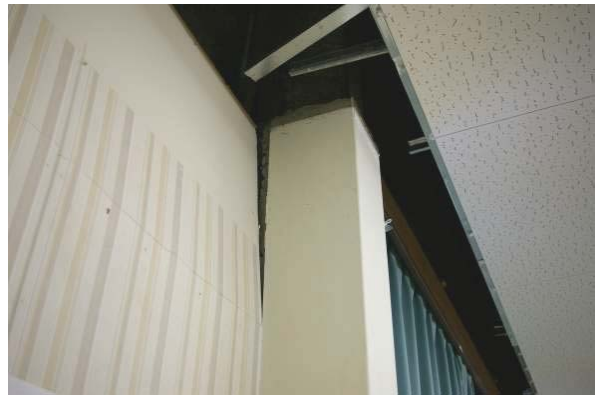
写真-10 会議室の天井被害
