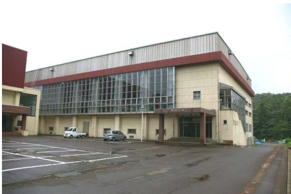
写真-30 建物H外観
