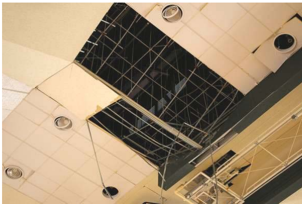
写真-24 脱落した天井箇所
