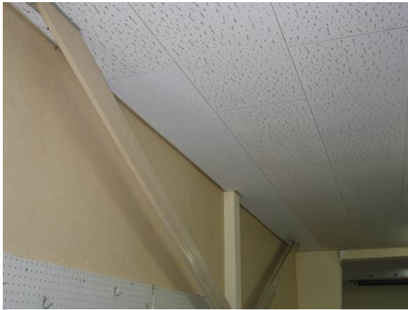
写真-9 放課後児童施設の天井被害（補修後）
