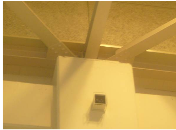
写真-33 RC造柱頭部の様子
