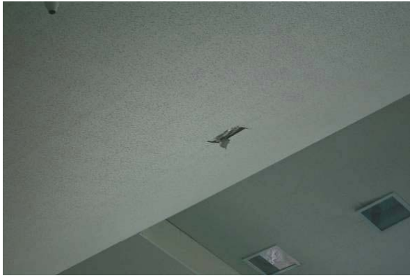
写真-18 50m プールの天井にあいた穴
