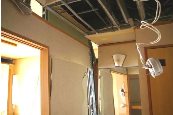
写真-45 天井や間仕切り壁が破損した客室
