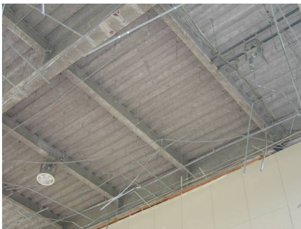
写真-14 天井が脱落した後の状況
