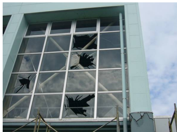
写真-12 ガラスの被害
