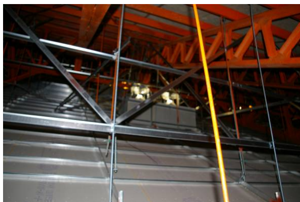
写真-6 天井裏の状況
