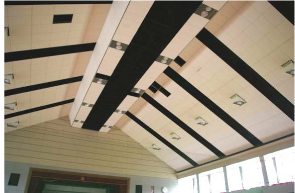
写真-29 同建物の体育館の天井
