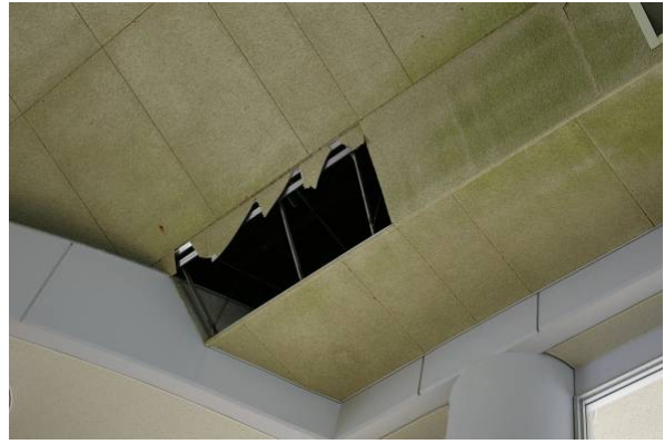
写真-19 レジャープールの勾配天井の被害
