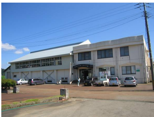
写真-1 建物 A 外観
