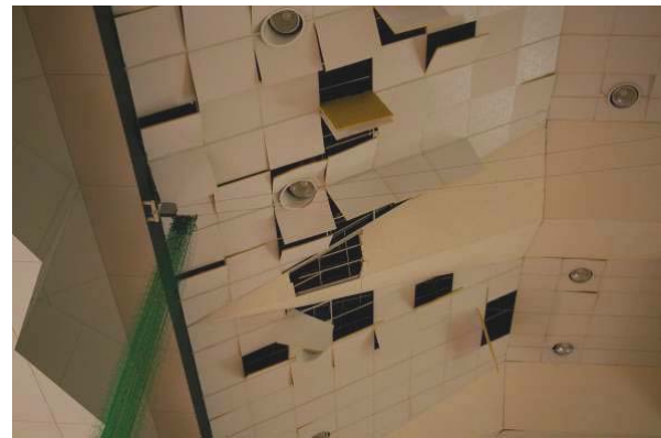
写真-25 脱落しかかったガラスウールボード
