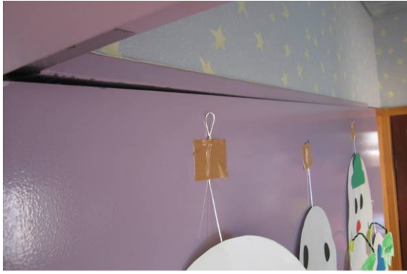
写真-39 納まらなくなった防火扉
