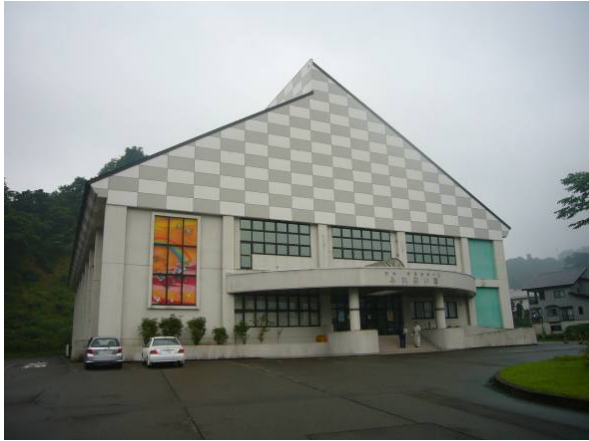
写真-22 建物F 外観
