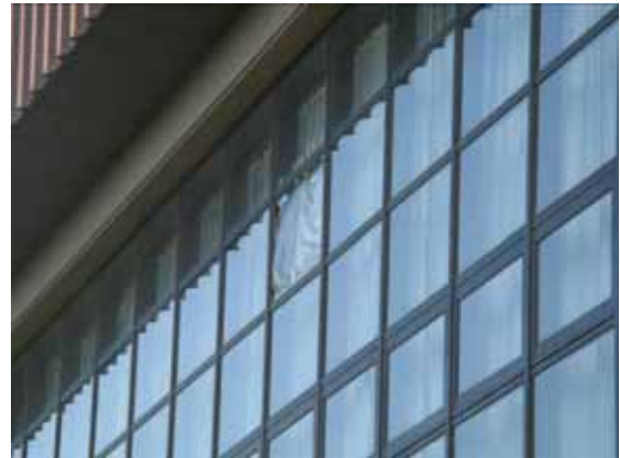
図-4.23 ガラスの破損
