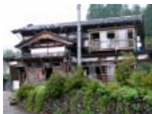
写真 1 伝統構法の被害例
