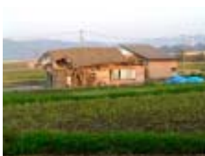
写真 2 2 階層崩壊の例
