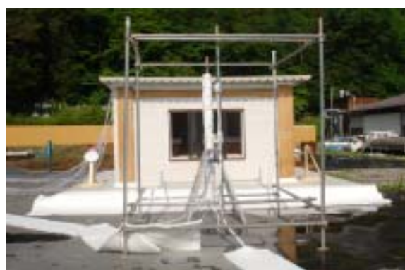
写真 1 実大火災実験建物概要
