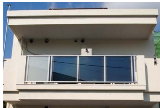
写真－1 ソーラー給湯システム実用化製品設置例
