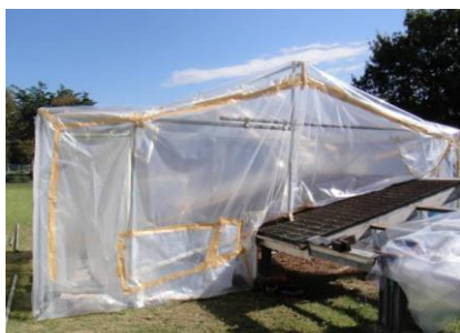
写真 1 仮設チャンバー設置状況
