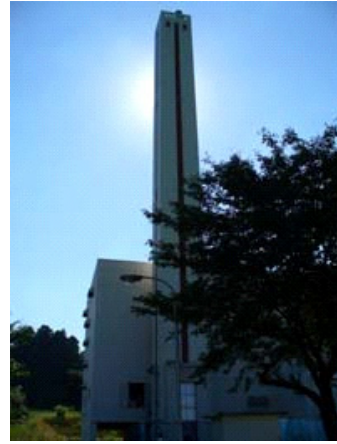
写真-6.6 小千谷市時水にあ る塔状工作物
