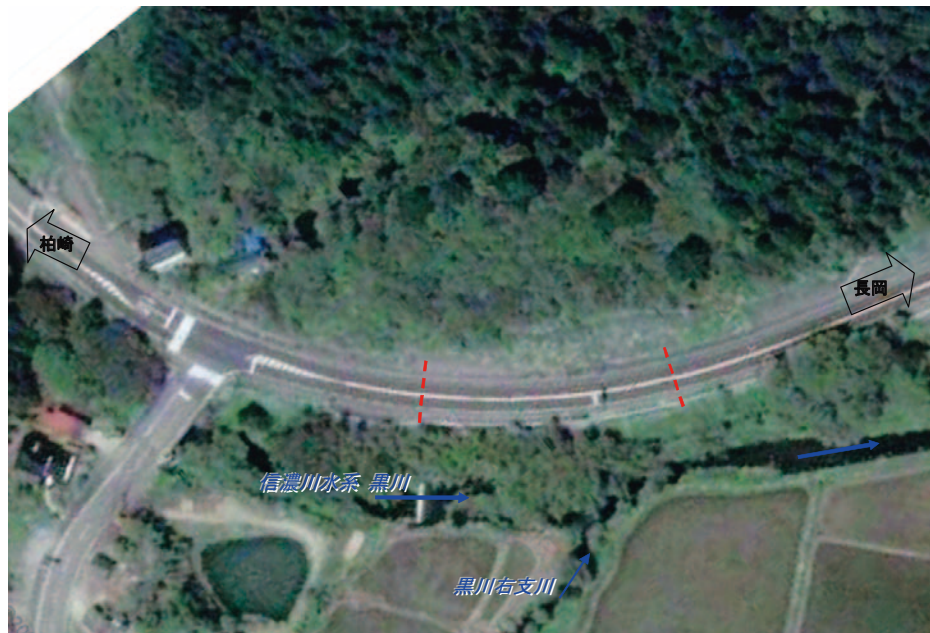
写真-8.3.9 地すべり発生前の空中写真（Google より）
