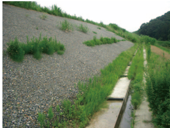
(a) 盛土のり面の降雨による変状痕（左：のり面の変状、右：補修跡）
