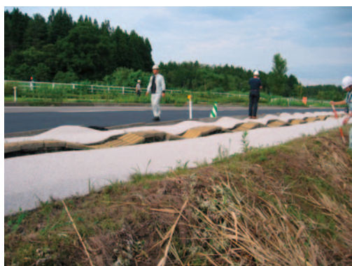
(b) 歩道の変状状況
