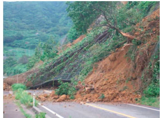
写真-8.3.22 国道に堆積した崩積土
