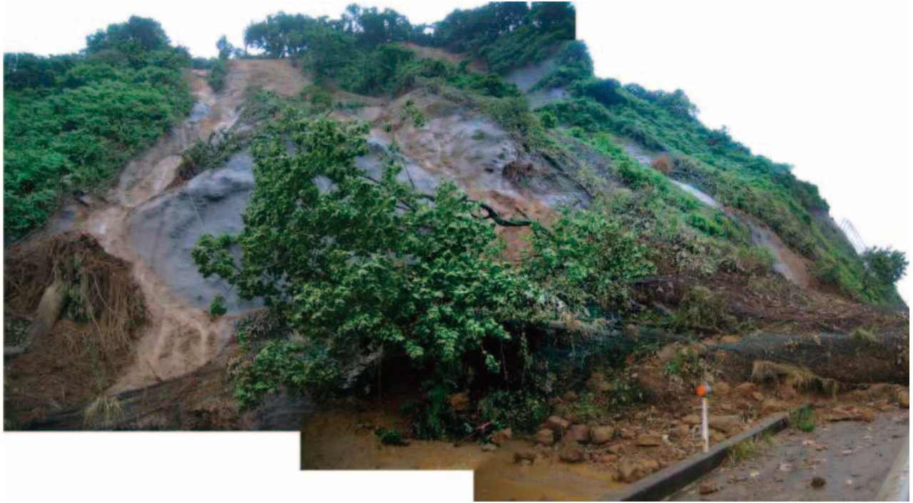
写真-8.3.20 道路に堆積した土砂
