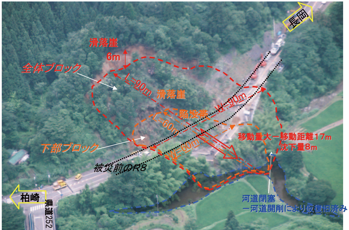
写真-8.3.8 大積地すべりの全景：ブロック界と滑動状況
