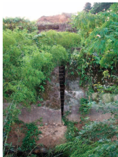
写真-8.3.7 路肩擁壁の変状
