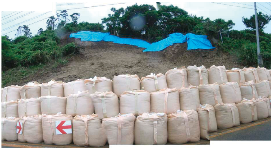
写真-8.3.25 上越市長浜（国道8号）の岩盤崩壊（斜面B）の全景
