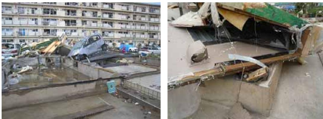
写真 5.4-1 上部構造が飛散した木造建築物
