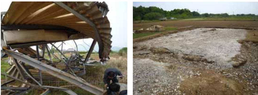
写真 5.5-1 崩壊した鉄骨造建築物
