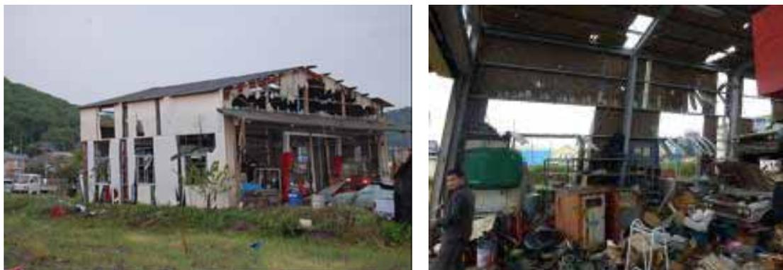
写真 5.6-1 傾斜した鉄骨造建築物
