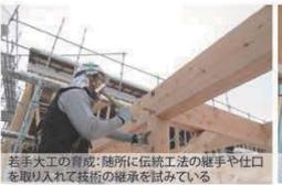
若手大工の育成：随所に伝統工法の継手や仕口を取り入れて技術の継承を試みている
