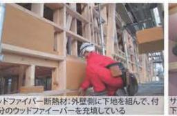
ウッドファイバー断熱材：外壁側に下地を組んで、付加分のウッドファイバーを充填している
