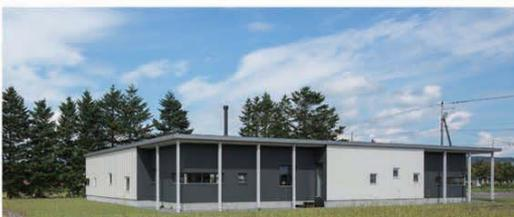
写真1：K-house 外観：無落雪フラットルーフとカラマツ材外装材を採用
