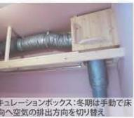
サーキュレーションボックス：冬期は手動で床下方向へ空気の排出方向を切り替え
