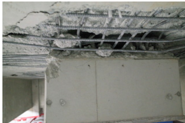
写真 5.7.2-17 鉛ダンパー取付け基部の被害（床スラブの破損）
