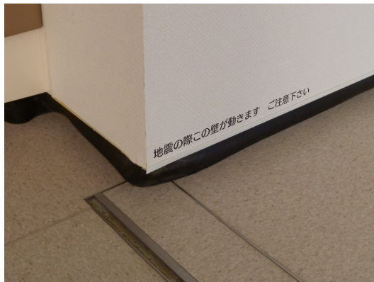
写真 5.7.2-9 建築物内部における免震表示 (右図は左図囲みの表示内容の拡大)
