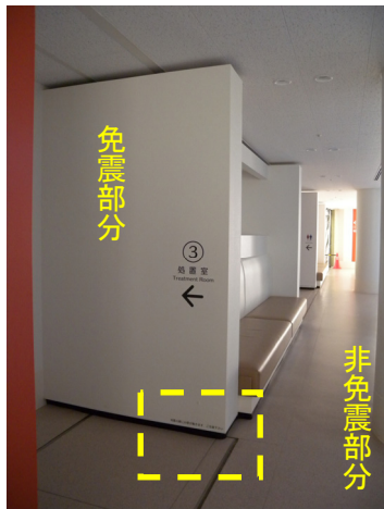
写真 5.7.2-9 建築物内部における免震表示 (右図は左図囲みの表示内容の拡大)
