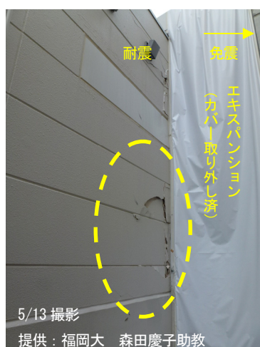
写真 5.7.2-61 エキスパンション部の破損と取り外されたカバー
