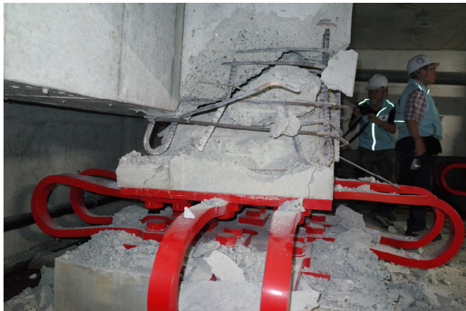
写真 5. 7. 2-54 鋼材ダンパー取付け基部の損傷②（南東部）
