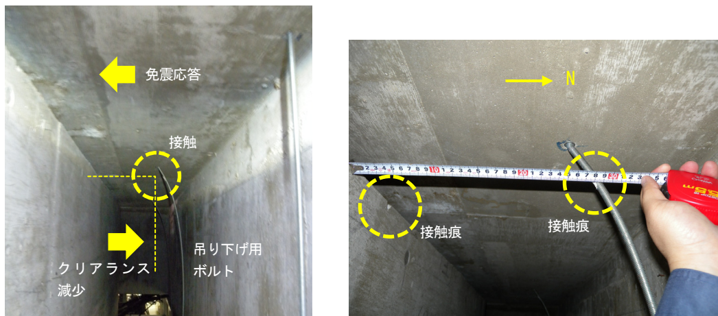
写真 5.7.2-28 配管吊り下げ用ボルトの変形（ボルトの接触痕から擁壁まで約28cm）
