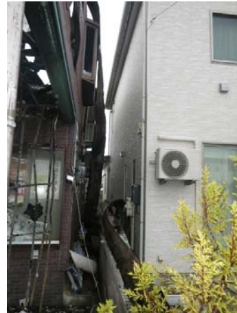
写真 3.3.5.2 西壁の状況（開口部が少ない）
