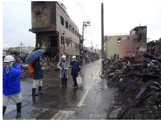
写真 3.1.4 火元建物より北側の仲道線の様子
