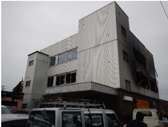
写真 3.3.13.1 事務所建物南東側の状況
