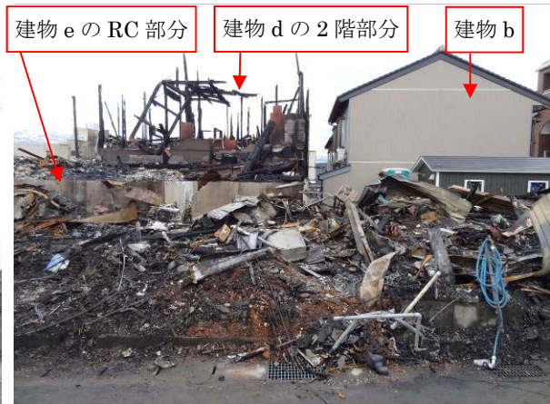
写真 3.3.9.3 建物 b 北側の火災跡と外壁面
