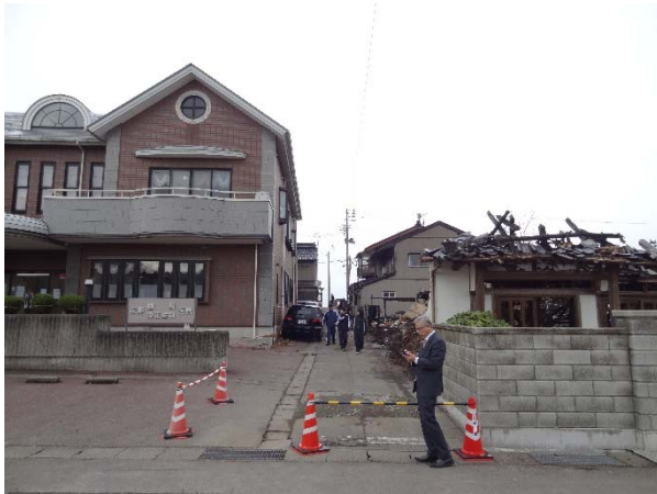
写真 3.2.2.11 西 6 焼け止まり線 (南→北)
