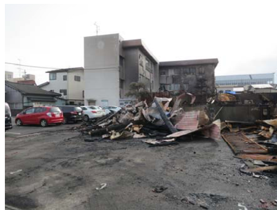
写真 3.2.1.8 南 5 焼け止まり線の様子 (北→南)
