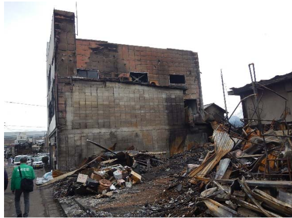
写真 3.3.13.2 事務所建物北側の状況
