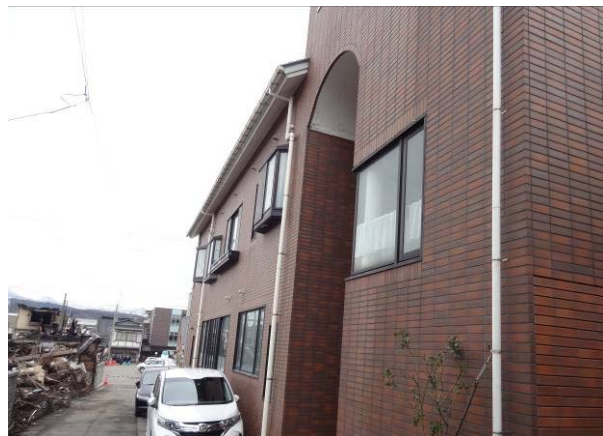
写真 3.3.7.2 東側道路の様子
