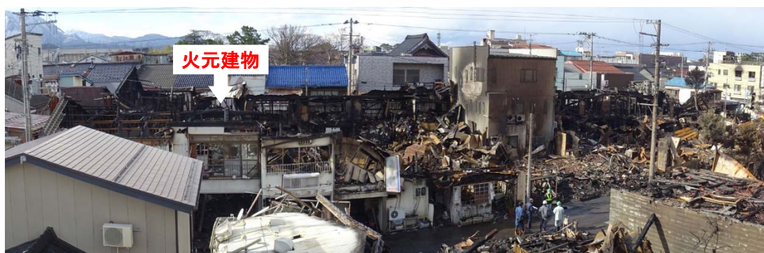
写真 3.1.2 火元建物背後の様子
