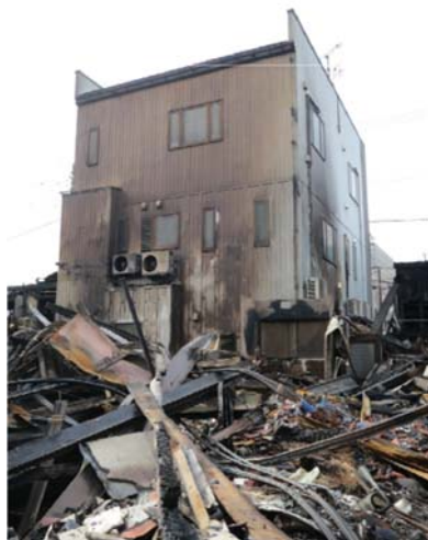
写真 3.3.2.2 東側壁面の様子
