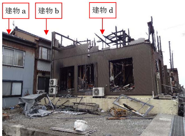
写真 3.3.9.2 建物 d の 1 階外壁の燃え残り
