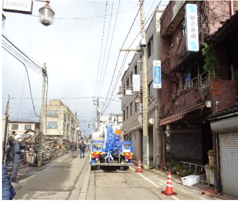
写真 3.1.3 火元建物より北側の仲道線の様子
