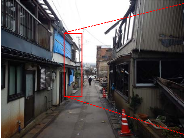
写真 3.2.3.6 東 5 焼け止まり線 (北側から撮影。右側が焼損区域)
