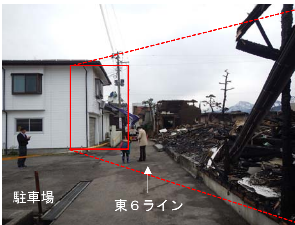
写真 3.2.3.8 東 6 焼け止まり線の焼け止まり線 (北側から撮影。右側は全焼した⑱飲食店)
