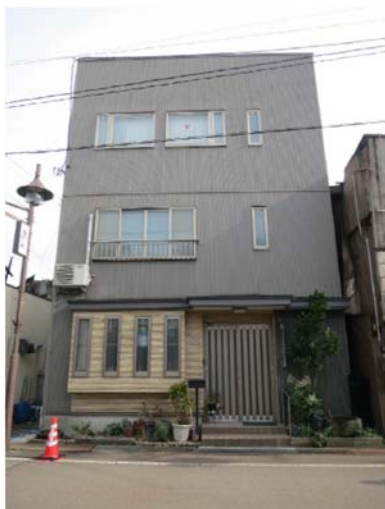
写真 3.3.2.1 仲道線側外観（西側）
