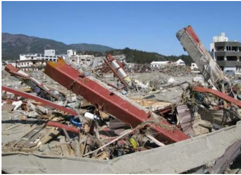
写真 6.3.1-3 1階柱の残存
