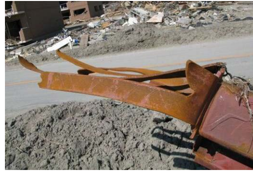
写真 6.3.1-4 引き裂かれた梁フランジ
