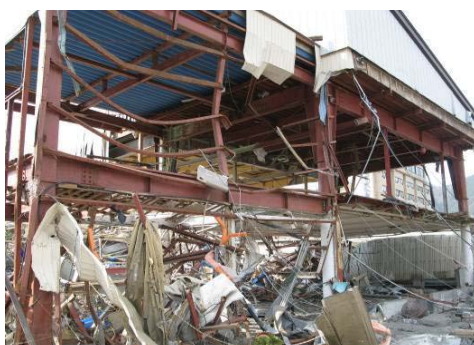
写真 6. 3. 1-15 間柱等の非構造部材の変形
