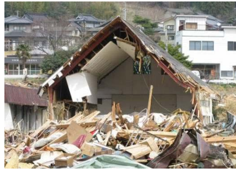
写真 6.3.1-10 傾斜した山形ラーメン架構
