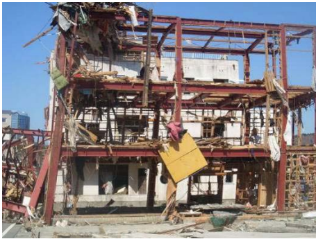
写真 6.3.1-9 傾斜した重層建築物
