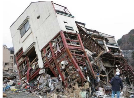
写真 6.3.1-6 3階建てS造の1階柱脚部の引き抜けおよび1階柱の座屈による転倒
