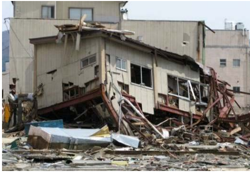
写真 6.3.1-7 2階建てS造の1階の崩壊
