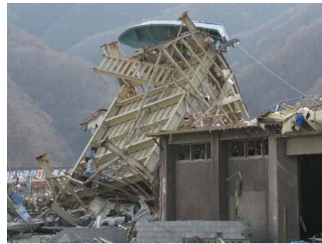
写真 6.3.1-2 柱脚部アンカーボルトの破断により移動したと考えられる建築物
