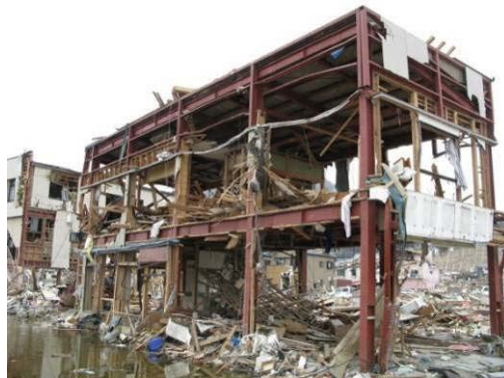
写真 6.3.1-11 残存するS造建築物
