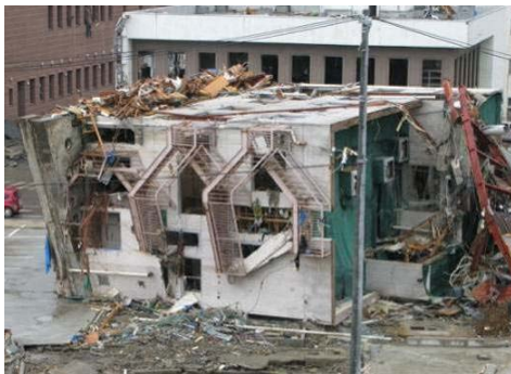
写真 6.3.1-5 3階建てS造の転倒
