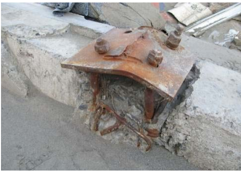
写真 6.3.1-1 柱脚部の破断
