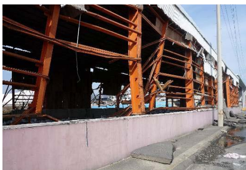
写真 6. 3. 1-13 柱の変形
