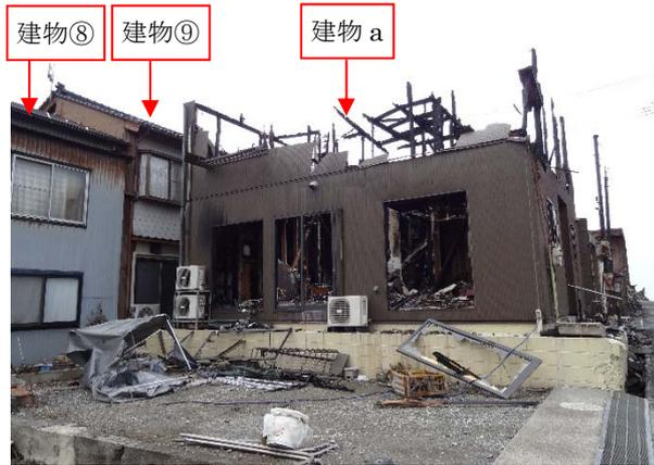
写真 5.3.9.1 建物 a の 1 階外壁の燃え残り
