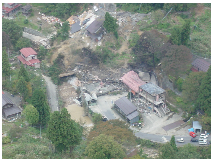
写真 9.1 長岡市濁沢町の火災及び土砂災害現場(6棟焼損)
