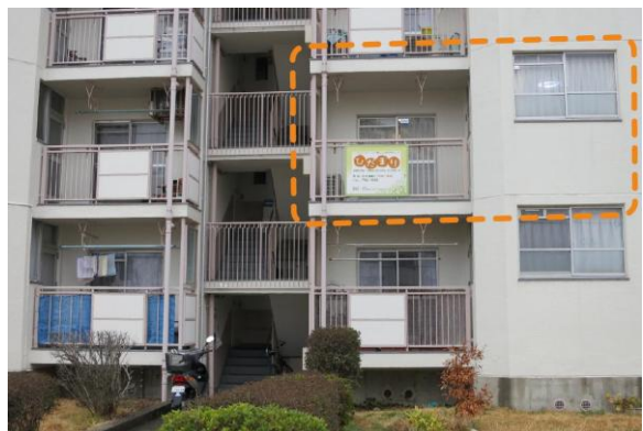
図4 視察事例2(神戸市の公営住宅を活用した自立支援拠点「あんしんすこやかルーム」)
