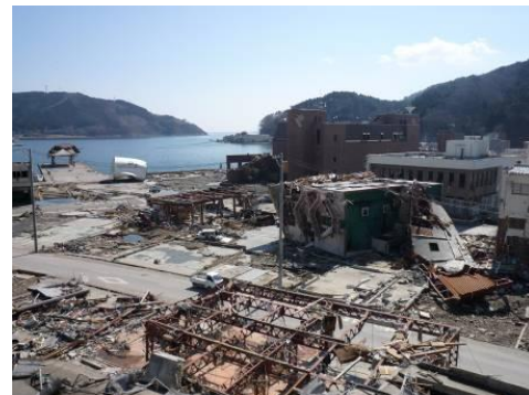
(b) 転倒した S 造建築物 (女川町)
