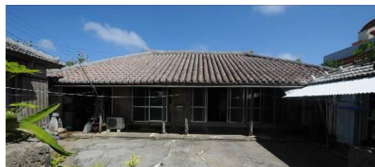
写真 1 伝統木造住宅
