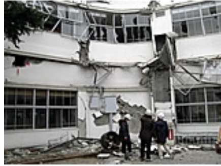
写真二 地震による被害建築物（福島県）
