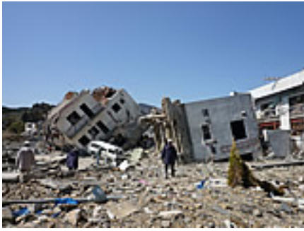
写真一 津波による被害建築物（宮城県）
