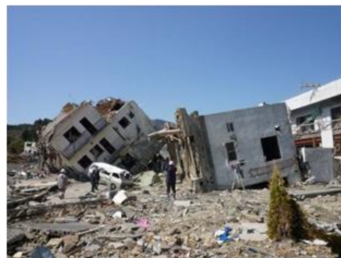
(c) 転倒した RC 造建築物 (女川町)
