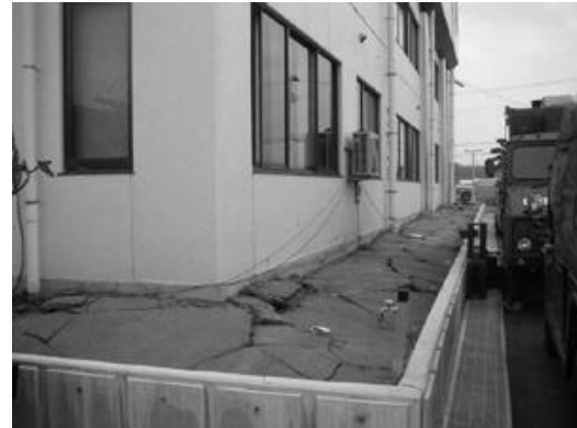
図1 基礎ずれが確認された地震被害
