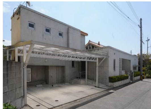
写真 6 RC 造住宅 (太陽光発電)
