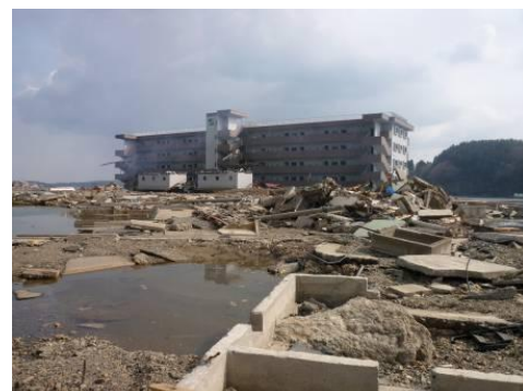
(a) 開口部や内装を被災した RC 造集合住宅
