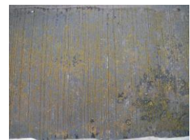
写真2 住宅屋根用化粧スレート外観
