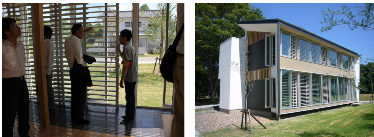
写真－1. 3. 2. 13 LCCM デモンストレーション棟 (左：棟内、右：外観)
