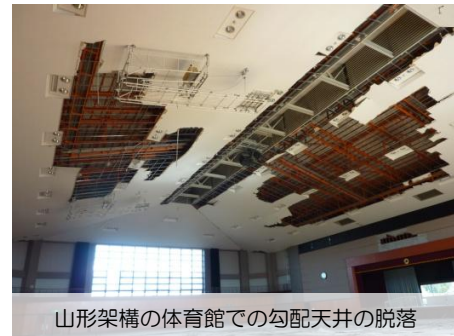
写真1 東日本大震災における天井脱落被害例
