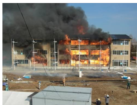
図5 木造 3 階建て学校の実大火災実験
