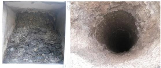
煙突断熱材には飛散性の高いアモサイト(茶石綿)が主として使用され、1960年代から1990年代にかけて広く用いられた。
