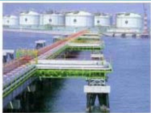
Figure 5.4.1 Incheon LNG terminal
