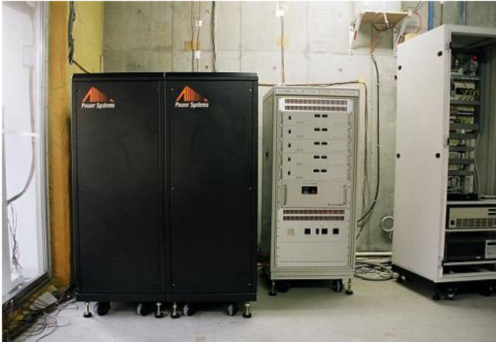
プロトタイプ概観<左より、キャパシタ、同制御装置、全体システム制御装置>
