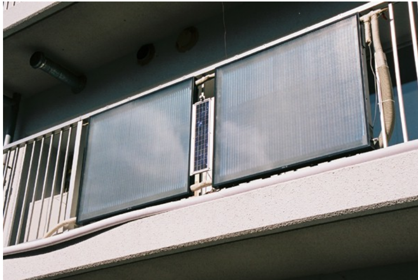
プロトタイプソーラーパネルを集合住宅手すりに取り付けた状況
