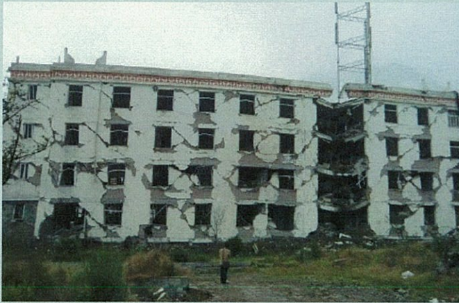
写真1. 1階が崩壊した学生寮(四川省映秀)
