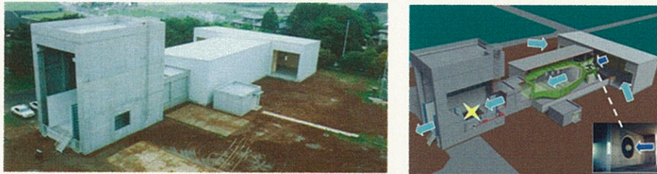
図2 火災風洞(火災と風との関係調べることのできる世界的にもユニークな実験施設)
