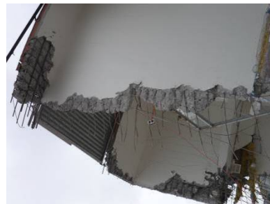
写真2 転倒した15階建集合住宅(コンセプション市)、引きちぎられた1階耐力壁
