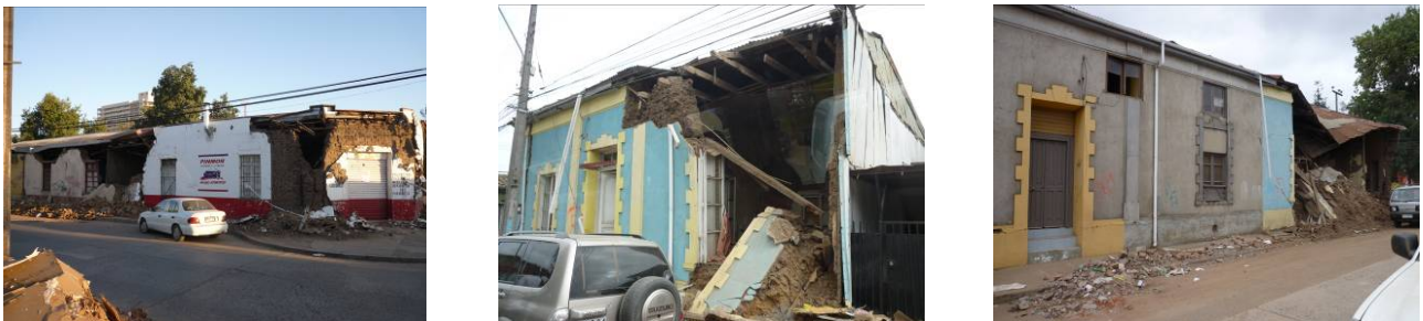
写真6 れんが造やアドベ造建物の被害 (タルカ、コンスティトゥション)
