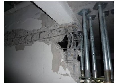
写真1 18階建集合住宅(サンティアゴ市)、地下駐車場のRC造壁が大破している
