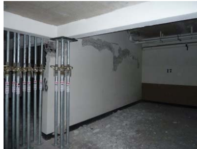
写真1 18階建集合住宅(サンティアゴ市)、地下駐車場のRC造壁が大破している
