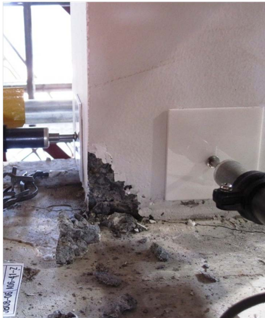
柱脚部の曲げ圧壊
