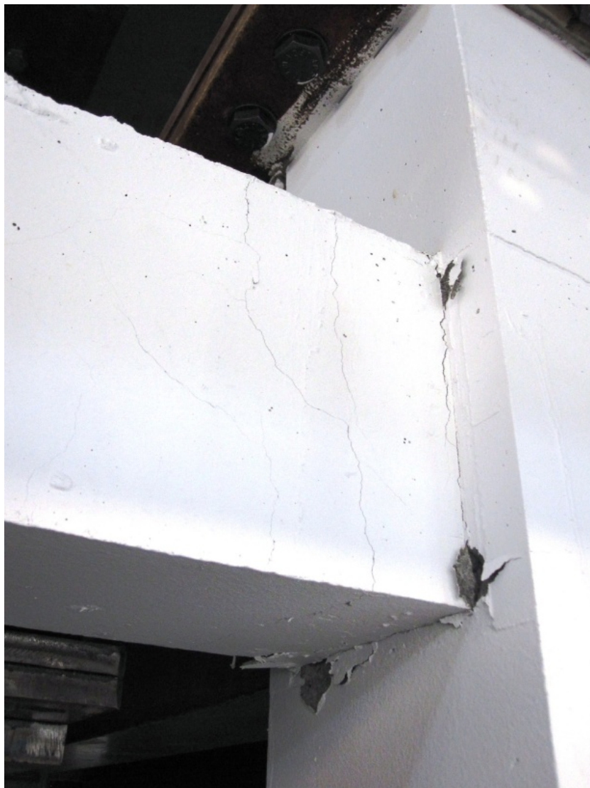
梁端部の曲げ圧壊
